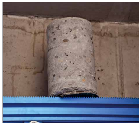
... und der ausgebohrte Rest!
