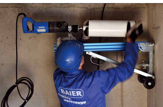
... anschließend werden die Maschine und die Bohrkronen montiert und die Bohrung gestartet.
