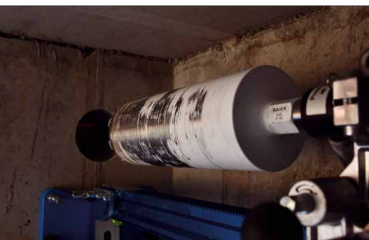
Nach der Bohrung bleiben ein perfektes Loch im Beton ...
