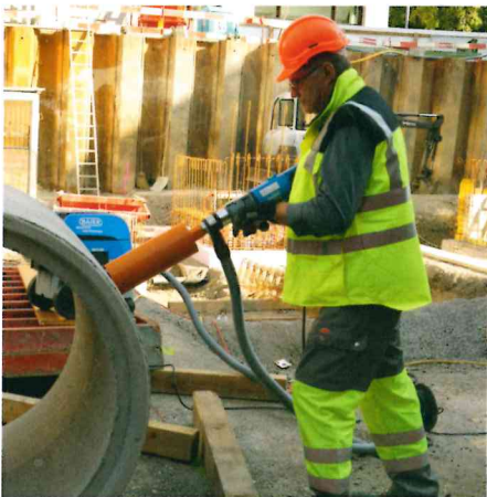
Trockenbohren von Anschlussbohrungen in Zementrohre
