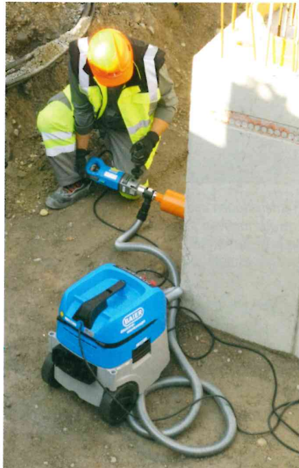
BAIER Trockenbohrsystem für Durchführungen in Beton
